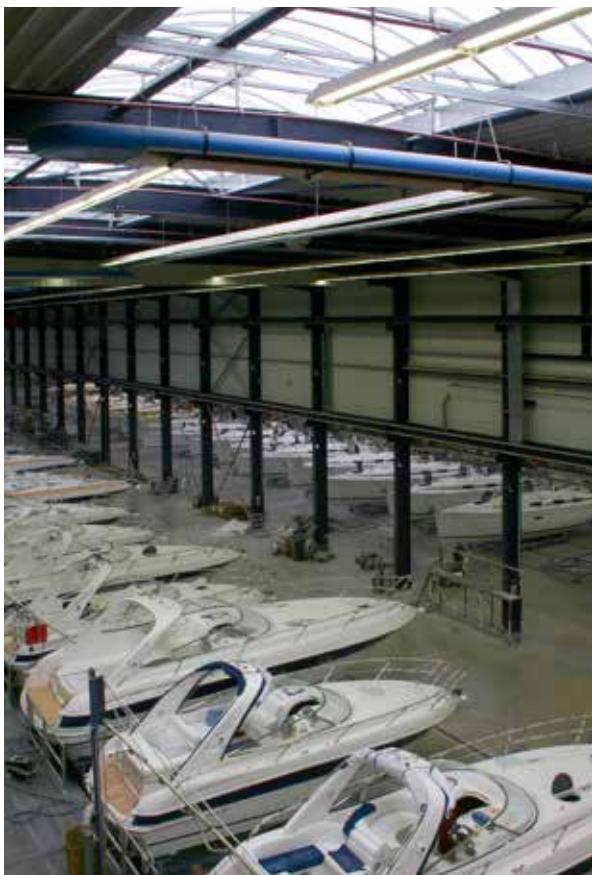
Werfthalle mit Dunkelstrahlern
