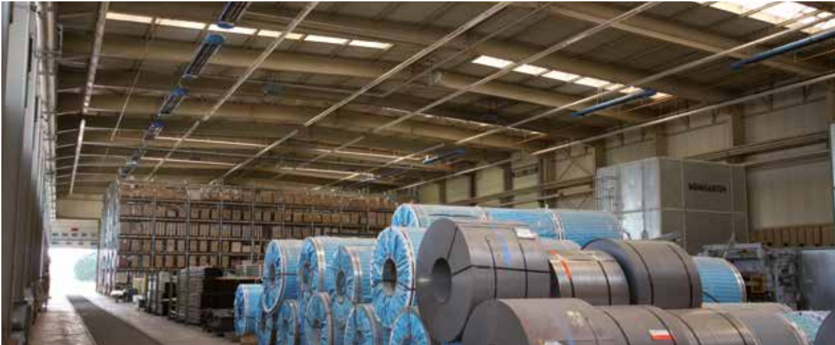
Lagerhalle mit Dunkelstrahlern
