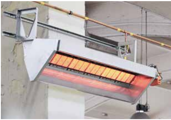
Hellstrahler in Montagehalle
