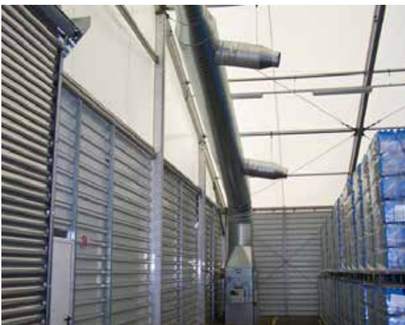
Lagerzelt mit Warmlufterzeuger
