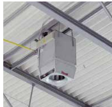
Warmlufterzeuger in Deckenmontage
