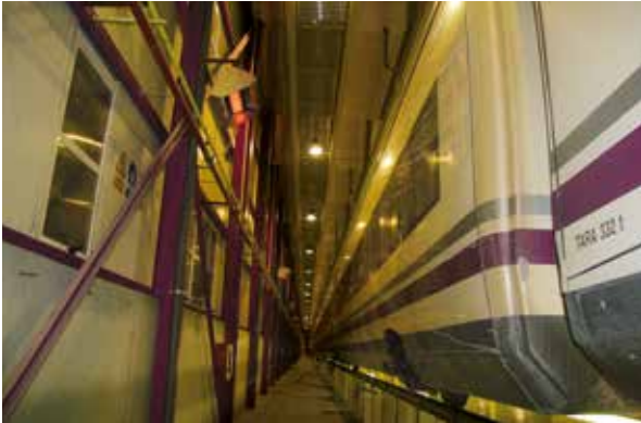
Bahnwartungshalle mit Hellstrahlern
