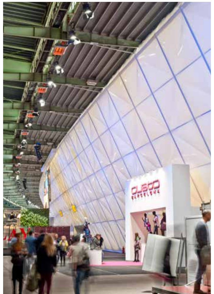
Flughafenhalle mit Hellstrahlern
