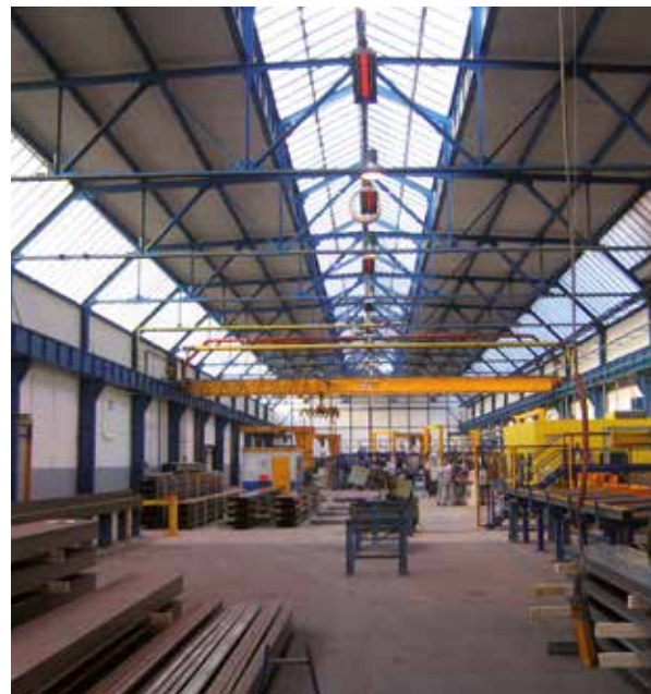
Produktionshalle mit Hellstrahlern
