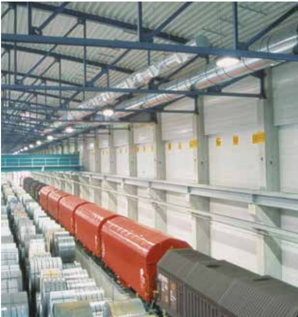
Coillager mit Warmluftsystem
