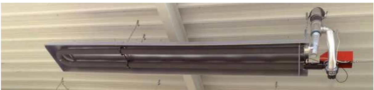
Dunkelstrahler: Durch spezielle Mischeinrichtungen werden Flammenlängen bis zu 6 m im Strahlrohr erzeugt, um eine gleichmäßige Wärmeverteilung zu erzielen.
