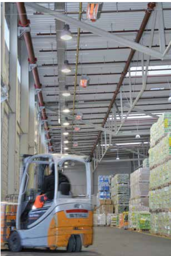
Distributionszentrum mit Hellstrahlern
