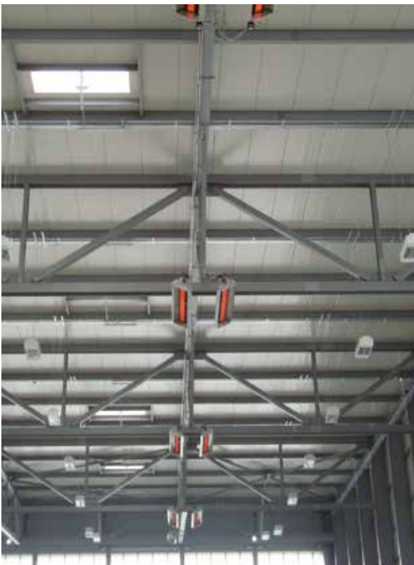
Hellstrahler in Deckenmontage
