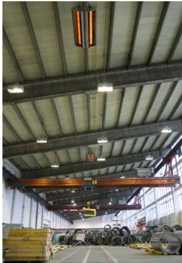
Werkhalle mit Hellstrahlern
